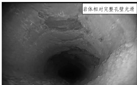
图2 钻孔孔内摄像图
