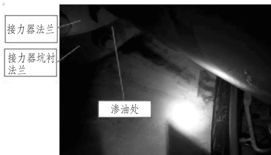
图1 接力器与坑衬渗油图
