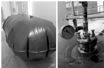
图 3 胶囊修复完成后打压
