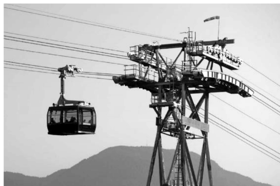
图 2 三线双轨索道实物
