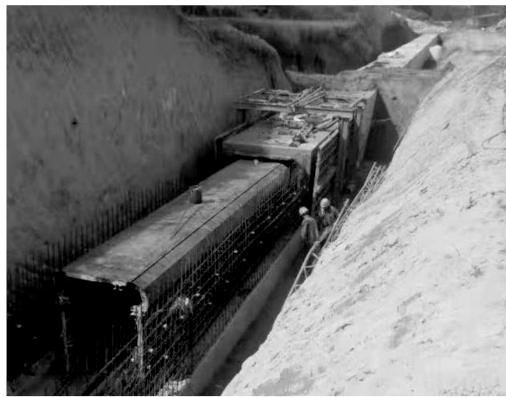
图 3 现场施工形象照片
