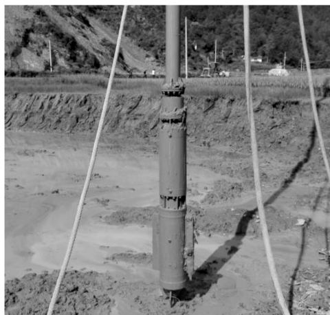
图2 振冲砂石桩的定位造孔
