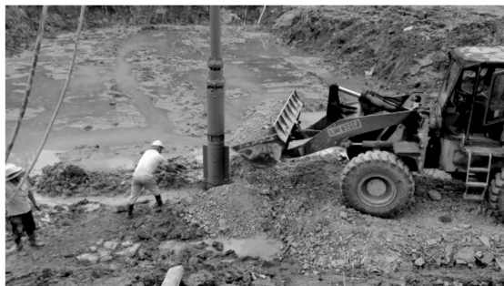
图3 振冲砂石桩填料与振密
