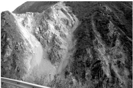
图 4 江嘴料场全貌及下游冲沟图
