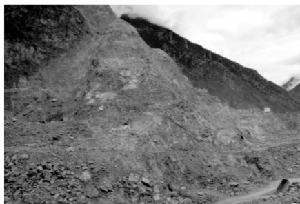
图 6 响水沟料场中下部顺坡小断层图
