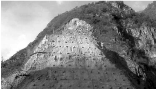
图 7 响水沟料场开口线上松动岩带及开采平台
