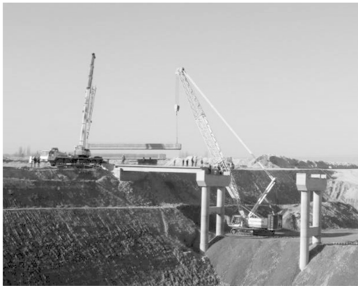
图 2 0#~1#空心板吊装
