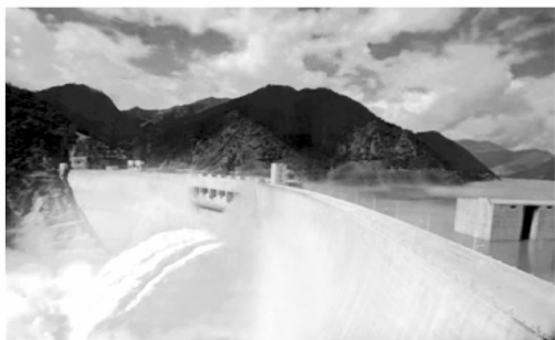
图 3 建成后的二滩水电站大坝
