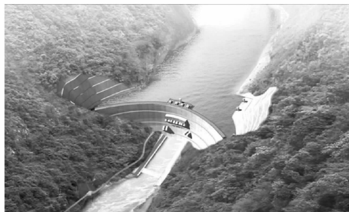
图 1 大岗山水电站大坝
