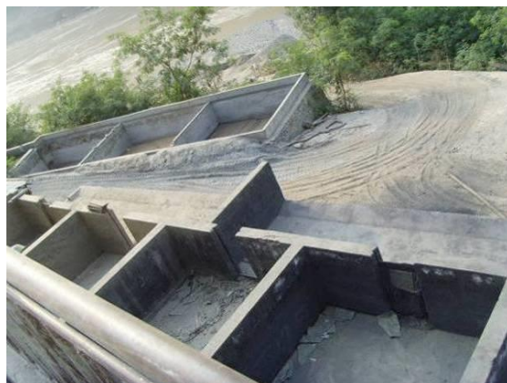
鑫国选矿厂尾砂池
