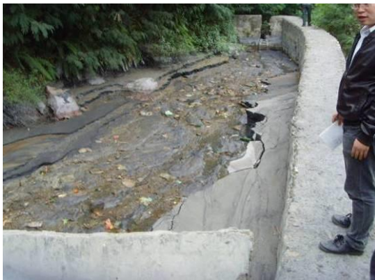
国丰铅锌选厂尾砂池现状
