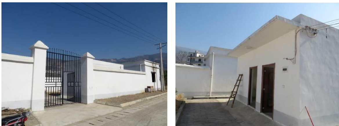
图 3.1.1-7 火地村康复村管理站污水处理站现状
