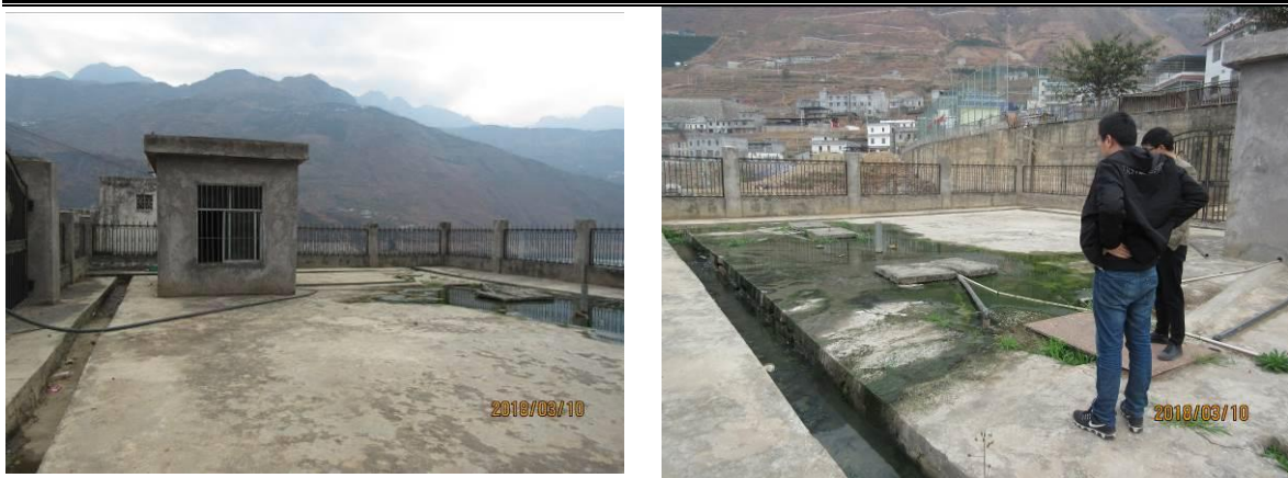
图 3.1.1-1 千万贯乡集镇污水处理站现状
