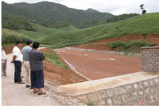
图 3.2.2-4 孟连县勐马移民安置点建成的垃圾填埋场
