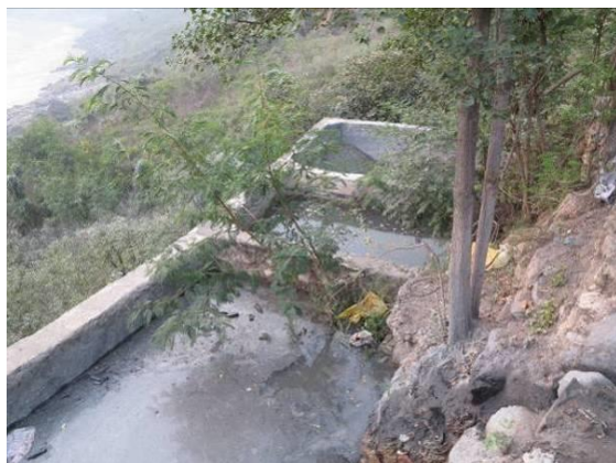
金阳县云鑫矿业尾砂池
