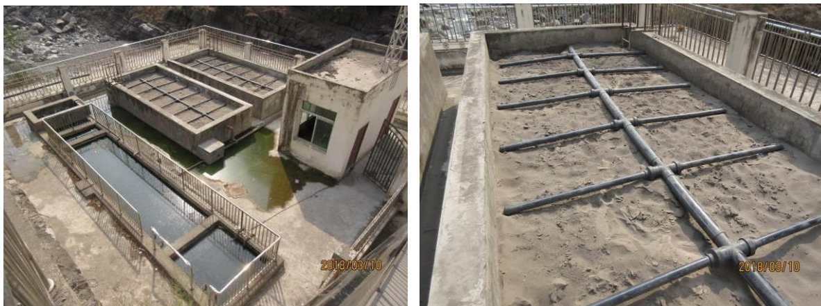
图 3.1.1-4 莫红乡集镇污水处理站现状
