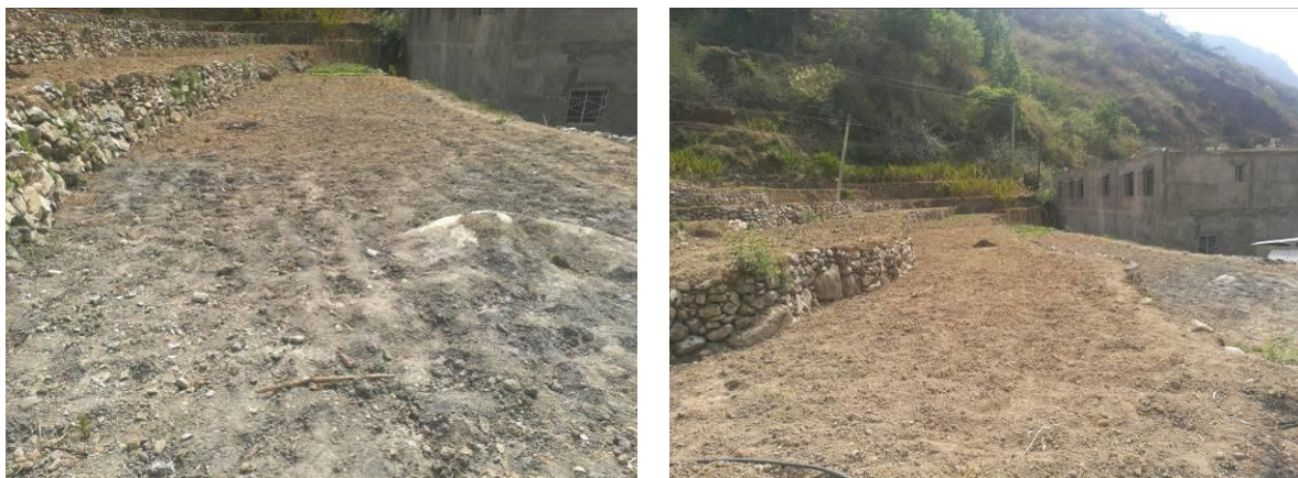
图 2.1.2-3 金阳库区尾砂贮存场现状（2018 年 6 月）
