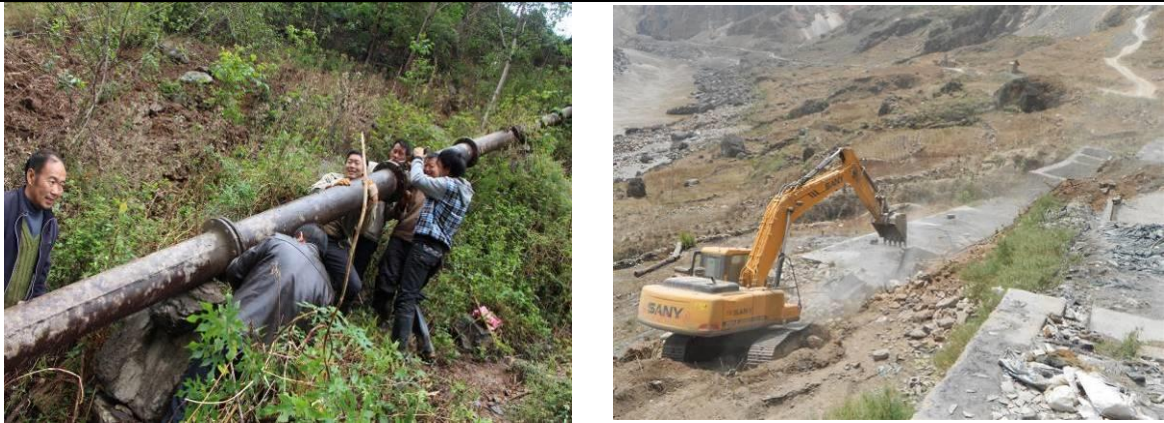
图 2.1.1-2 溪洛渡水电站库区建(构)筑物清理现场照片
