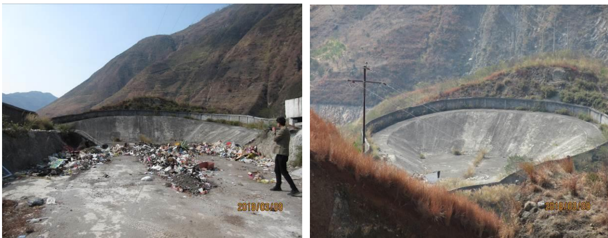
图 3.2.1-2 岩脚乡垃圾填埋场现状
