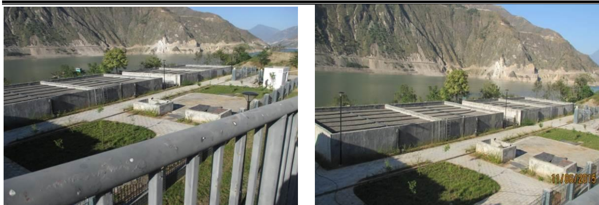
图 3.1.2-3 大兴新街安置点污水处理站现状
