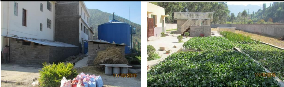
图 3.1.1-12 西溪乡安置点沼气池及乡镇污水处理厂
