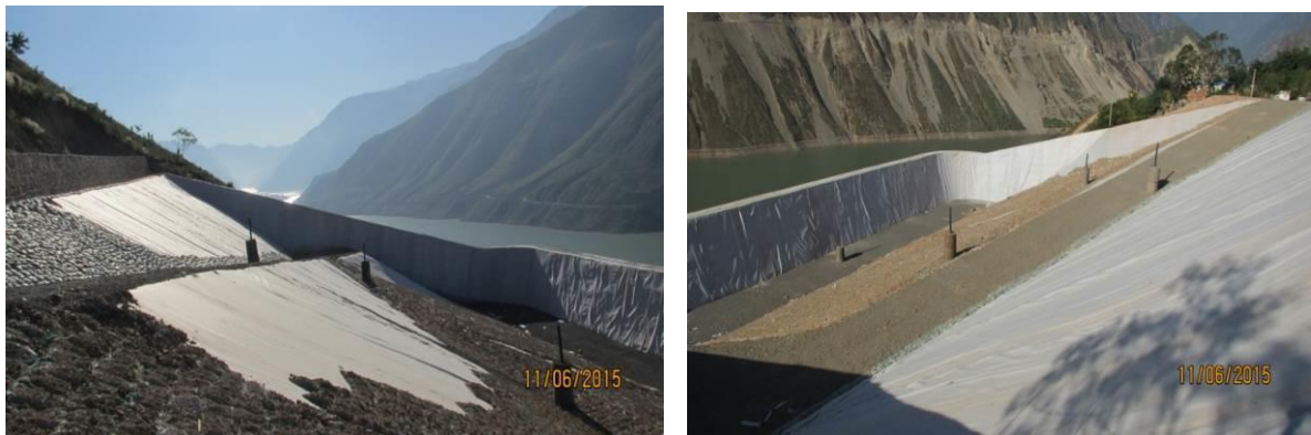
图 3.2.2-2 大兴集镇安置点垃圾填埋场现状
