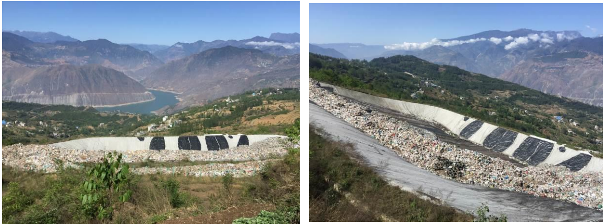
图 3.2.2-1 黄坪集镇安置点垃圾填埋场现状
