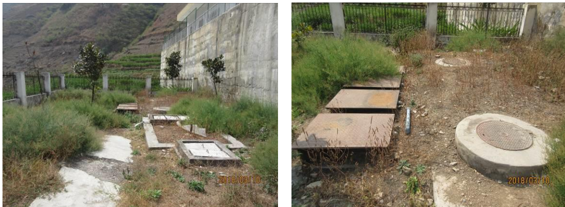
图 3.1.1-2 曲依乡集镇污水处理站现状
