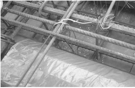
图2 空心楼盖铁丝上下绑扎
