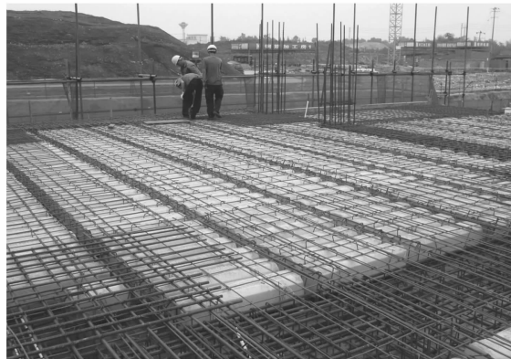
图1 现浇混凝土空心楼盖内置模绑扎施工现场
