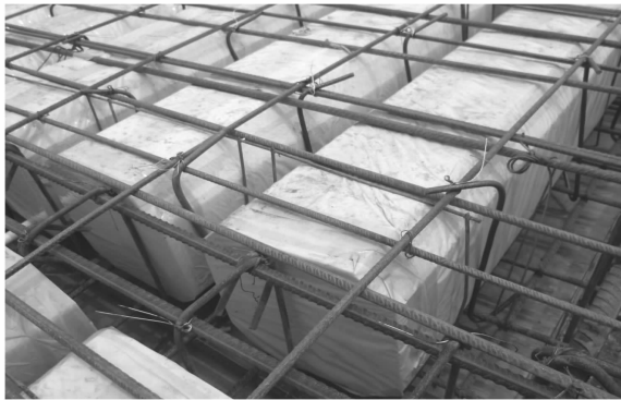
图3 保证楼板整体性和抗浮绑扎的拉钩
