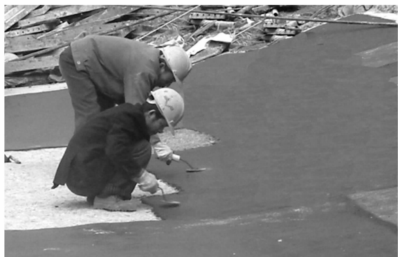
图5 涂抹环氧砂浆施工
