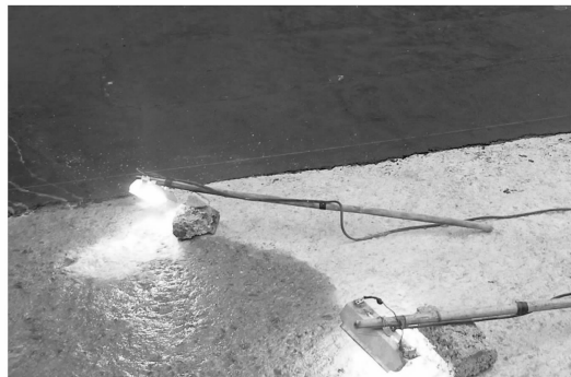
图 4 修复面干燥施工
