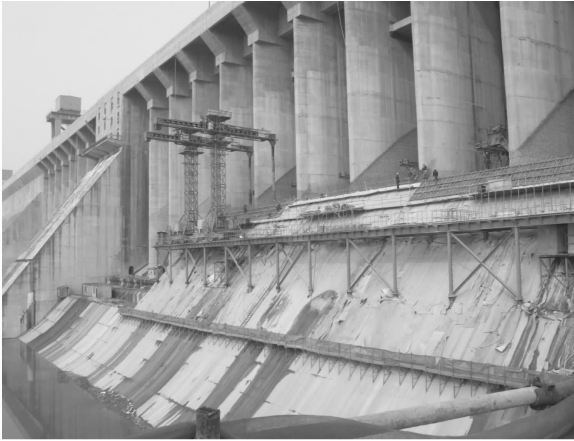
图 1 坝下施工栈桥及布料机系统
