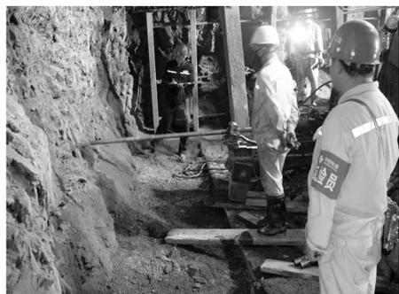
图 3 超前水平钻孔探测法的实施情况
