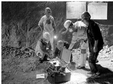
图 2 TSP 地震波反射法的实施情况
