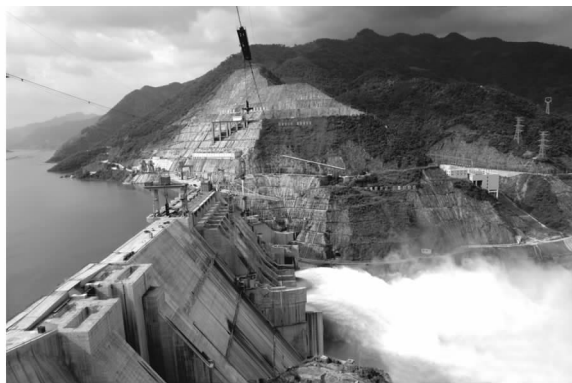
世界最高的碾压混凝土大坝——广西龙滩水电站 (田毅 摄)
