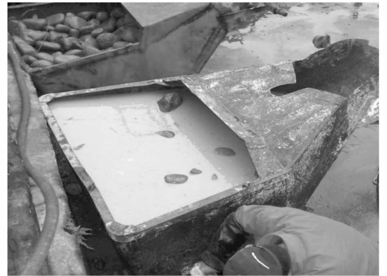
图2 采用不分散浆液灌注后情况
