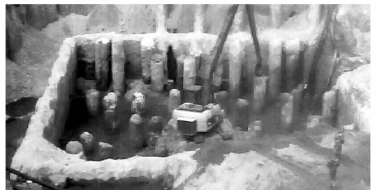
图6 集水井四周地连墙隔水
