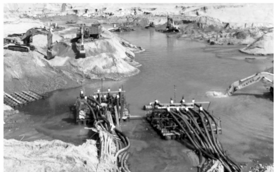
图 2 基坑集水坑照片
