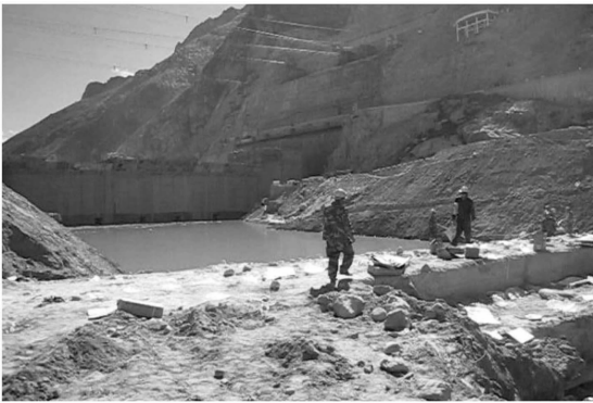
图8 防渗墙爆破拆除前周围环境
