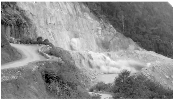
图 3 水介质换能爆破烟尘照片
