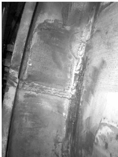
图2 转轮室裂纹焊接处理后
