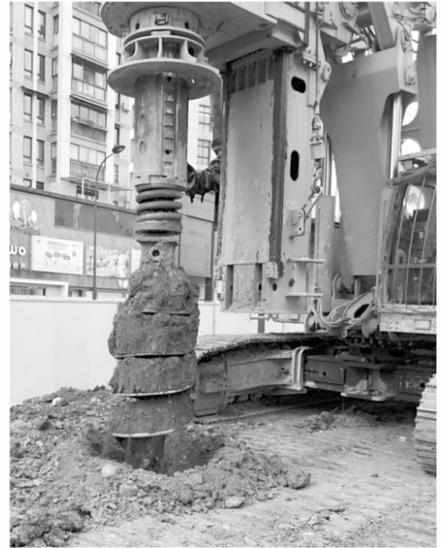
图 3 短螺旋钻施工形成的“土柱”图
