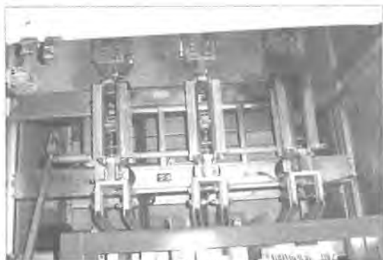
图4 短路时2#机组出口隔刀烧毁示意图
