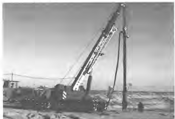
图 3 振冲造孔施工图
