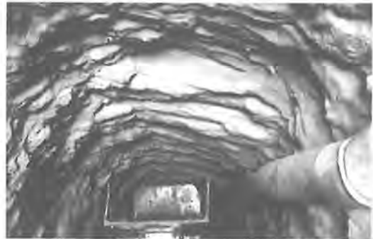
图4 开挖初期质量较差示意图
