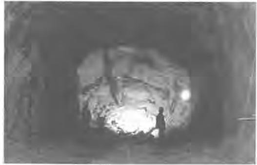
图3 初期爆破进尺短、效果差示意图
