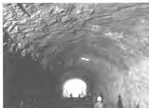
图9 优化后的调压上室开挖效果图
