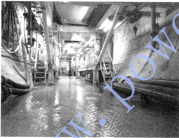
图 1 涌水洞段照片
