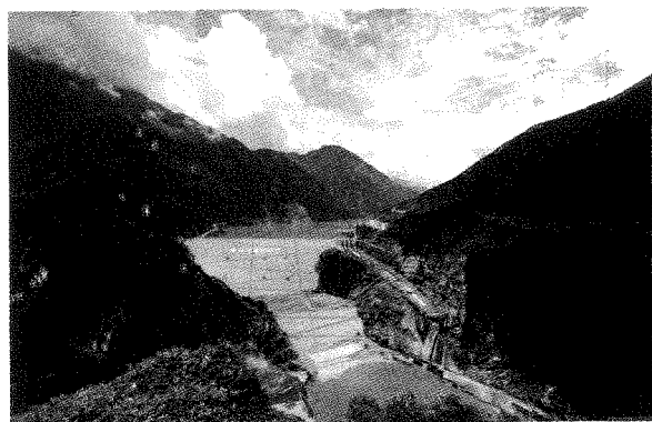
瀑布沟大坝 冉开金摄
