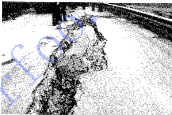
图1 道路开裂示意图
