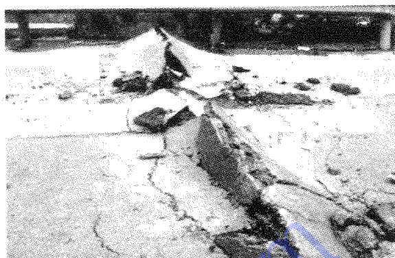
图6 道路挤压隆起示意图
