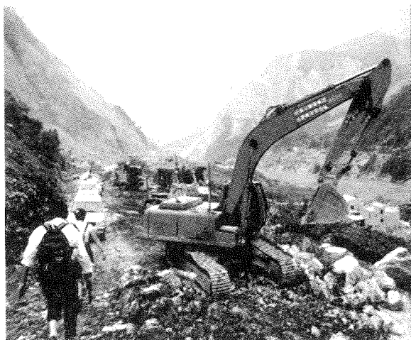
图2 某损毁公路抢险现场
