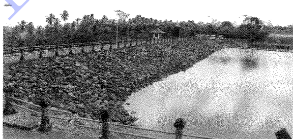
图12 Telaga Tunjung 坝上游坝面
