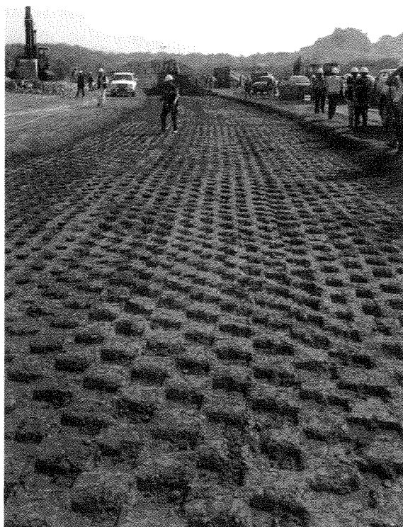
图3 Jatigede 大坝粘土心墙施工
