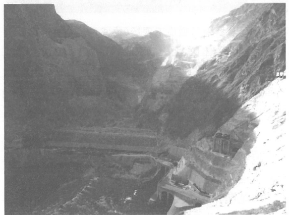
围堰和导流洞(卓正昌 摄)
