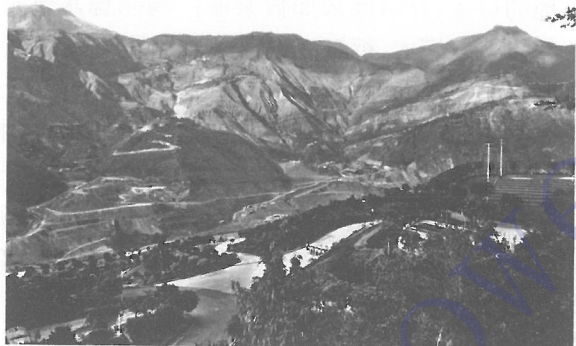
从营地鸟瞰施工现场(卓正昌 摄)
