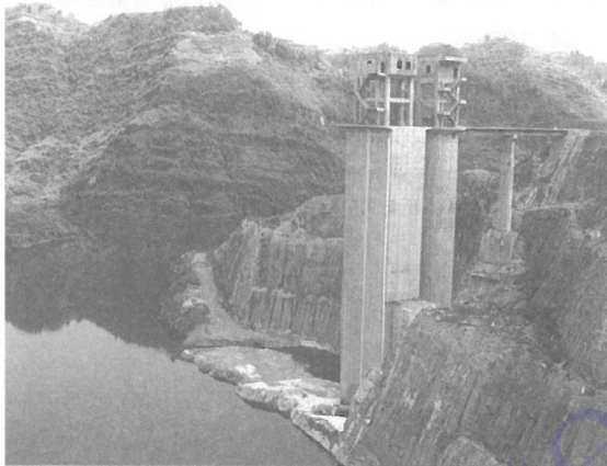
图3 工程蓄水至高程391m时的交通桥
