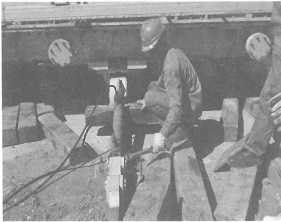
图4 水平夹具、轨道与液压推杆图
