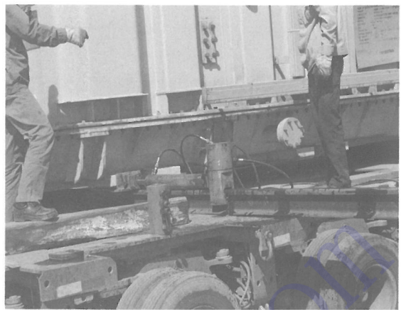
图2 夹紧钳千斤顶与轨道连接图
