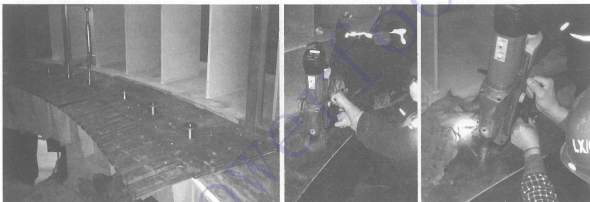
图2 螺栓孔定位及钻铰
