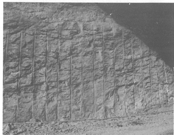
图2 中层预裂爆破效果图
