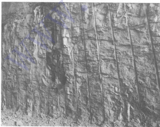
图2 中层预裂爆破效果图
