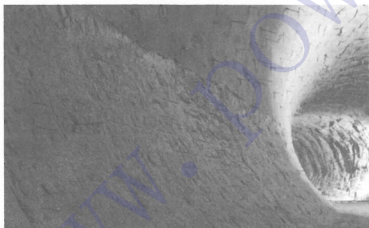
图4 3#泄洪洞 K1 + 110 段中层保护层开挖效果
