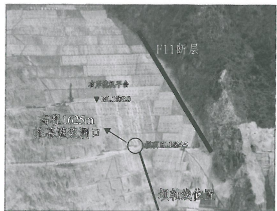
图2 黄登水电站右岸坝肩开挖面貌图 管理人员在分析其走向后判断该断层可能会与右
