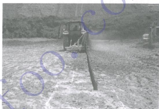
图2 改造后的拖拉机式刻槽机进行刻槽作业
