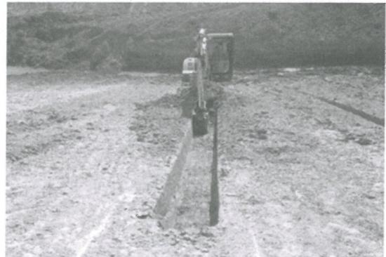
图3 刻槽后采用小型挖掘机开挖沟槽
