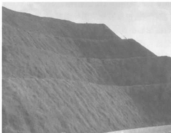
图 6 边坡 TBS 植被防护效果初现
