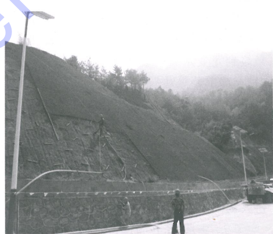
图5 厚层基材喷播施工
