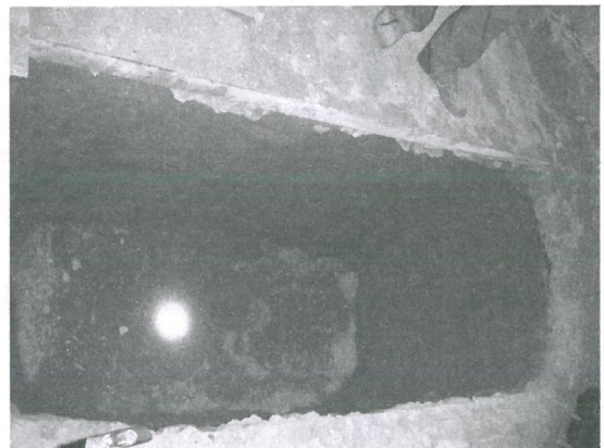
图3 德威大堰引水工程隧洞出口段底板0+369.7处换填坑图
