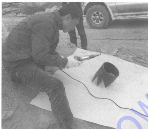
图5 正在进行的PE膜与PE管焊接试验
