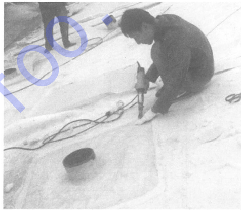
图6 正在进行的PE膜与PE管焊接施工
