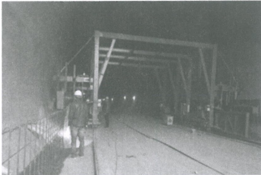
图3 采用新技术完成的自动桁架效果图
