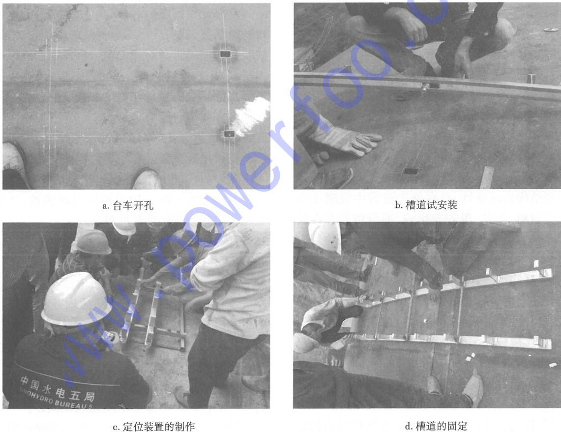
图5 槽道开孔安装及组装施工图
