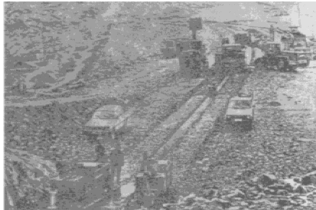
图2 挪威的沥青混凝土铺料机工作在斯泰尔瓦津坝上
