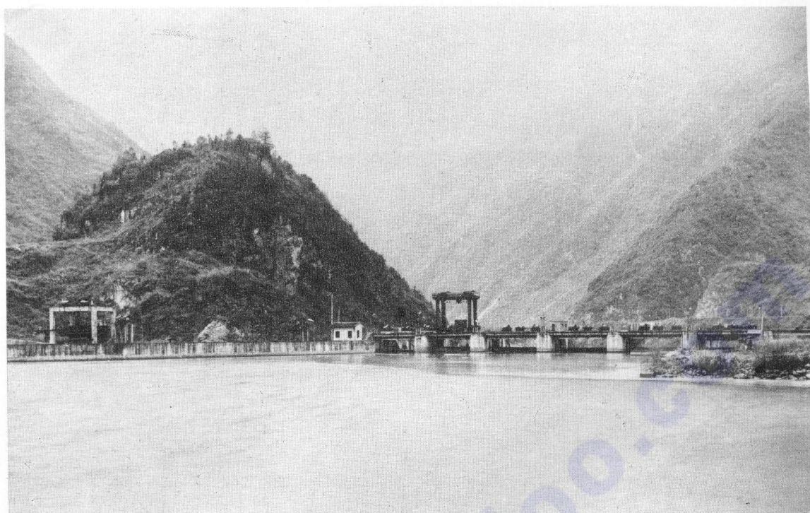
映秀湾水电站首部枢纽全景（一） （上游下视）
